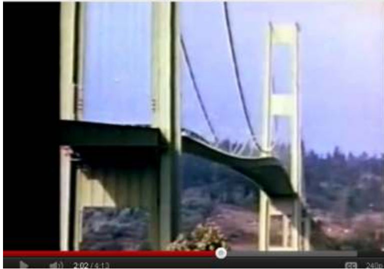
Слика 22: Осциловање моста Tacoma Narrows Bridge
