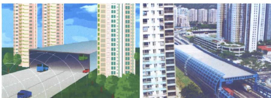
Slika 51- Ilustracija efekta tunela zatvorenog tipa sa prikazom izgrađenog tunela pored saobraćajnice
