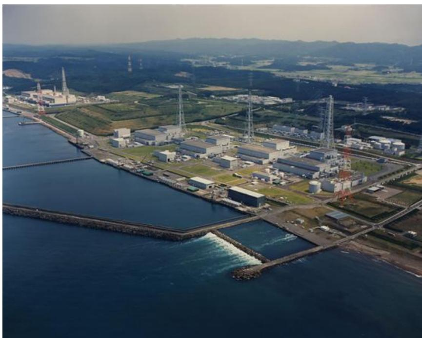
Slika (9) Najveća nuklearna elektrana na svetu Kashiwazaki-Kariwa sa 5 x 1067 MW i 2 x 1315 MW nuklearnim reaktorima, tip reaktori III Generacije – Poboljšani reaktor baziran na ključaloj vodi ABWR reaktori
