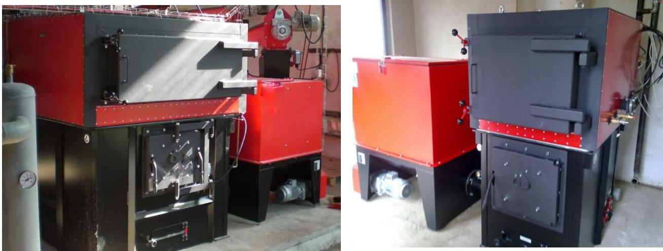
Slika (47) vizuelni prikaz peći od 500 kW i peći od 150 kW, namenjene za sagorevanje drvne sečke
