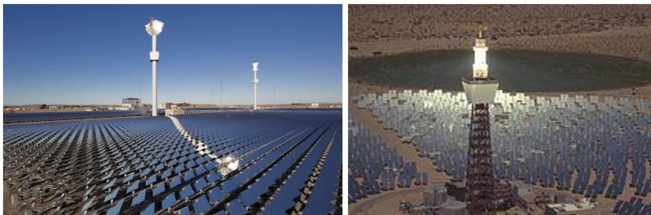
Slika (29) Izgled heliostatskih sistema u SAD-u, elektrana od 5 MW i 2 MW električne snage
